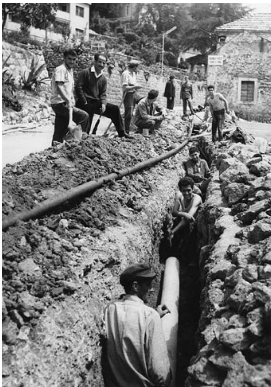
Polaganje cjevovoda AC 200 mm vodovoda »Lovac« na Toploj 1954. godine
