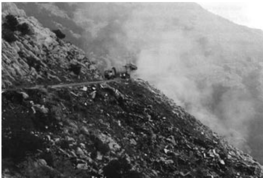
Deponija Komunalnog preduzeća Herceg-Novi na Dugunji
