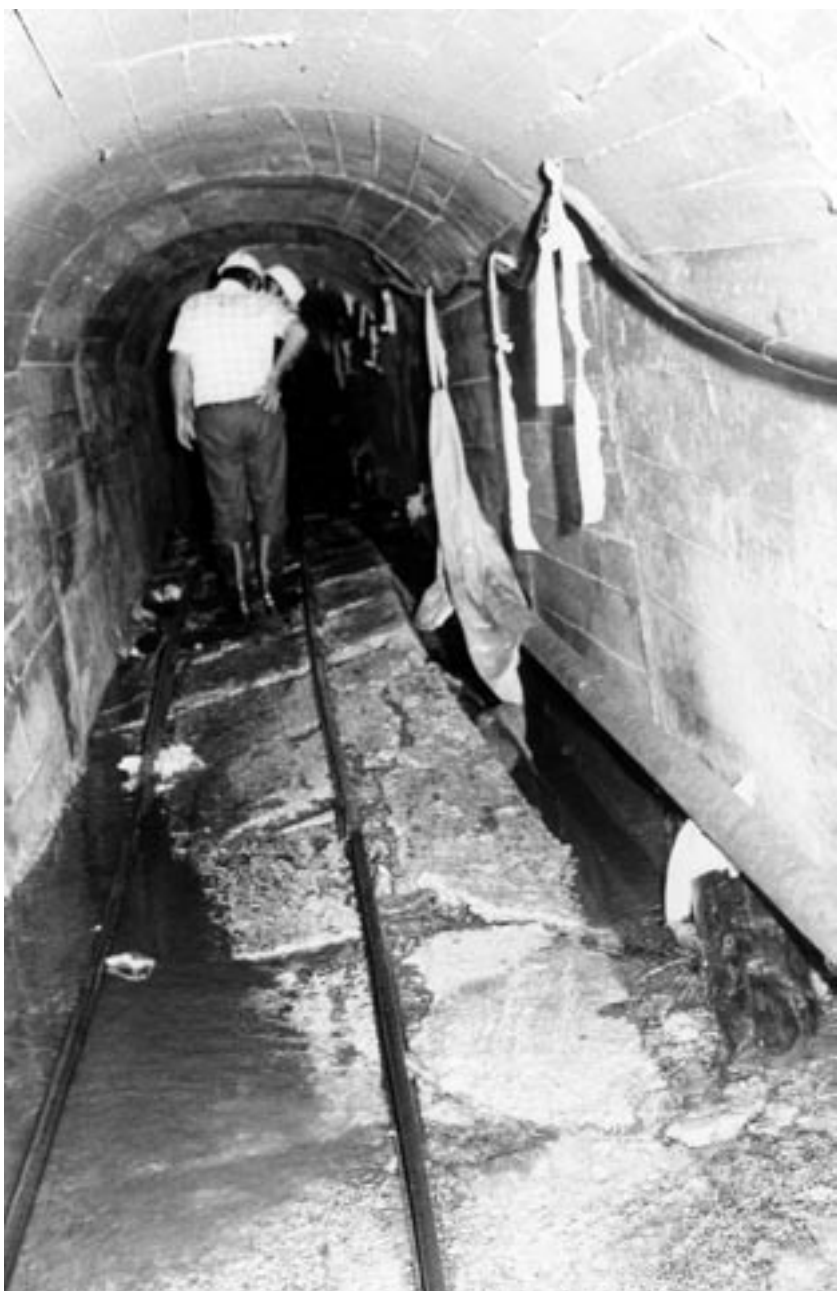
Drenažna galerija »Potkop« u Mojdežu prilikom vodoistražnih radova 1971. godine
