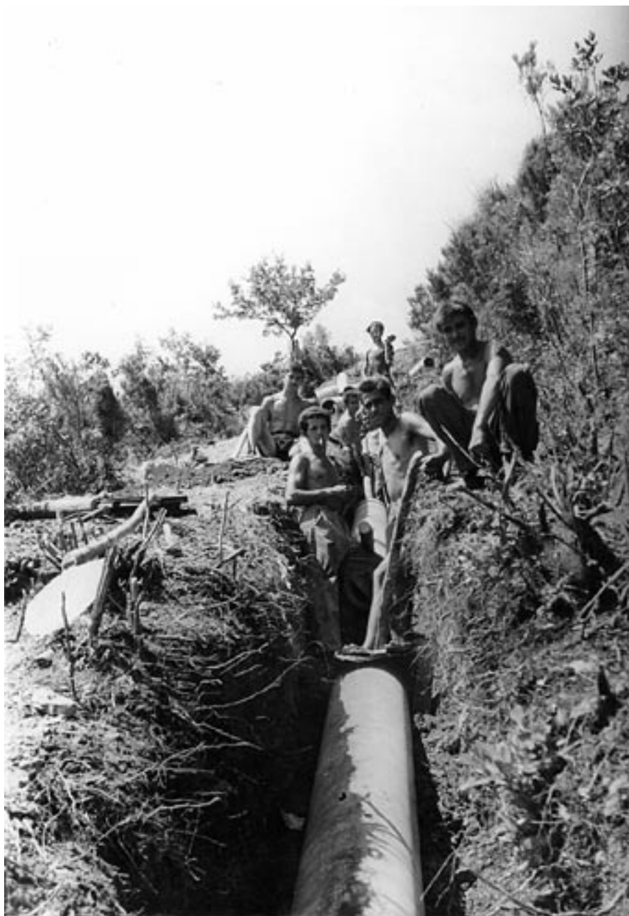
Polaganje potisnog cjevovoda AC 300 mm od pumpne stanice »Opačica« prema Herceg-Novom 1963. godine
