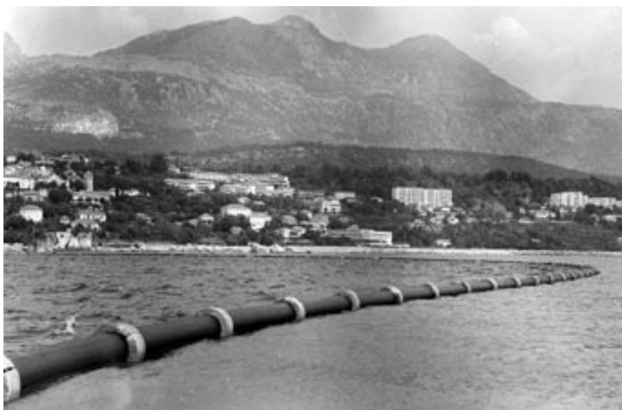
Polaganje ispusta u more kolektora gradske kanalizacije
